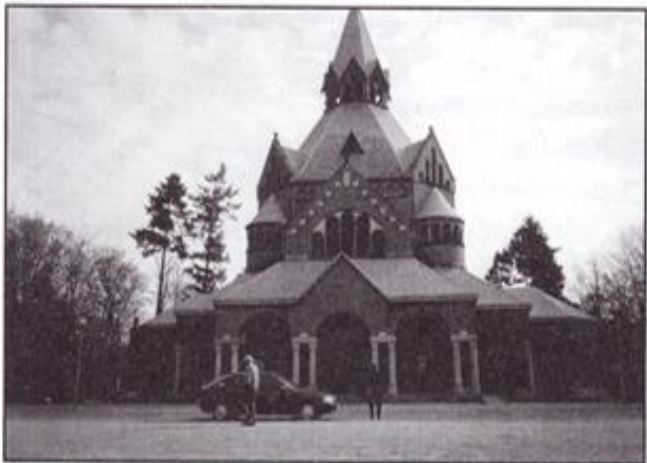
W górującej nad cmentarzem kaplicy pogrzebowej znajduje się chłodnia dla 50. zmarłych i pomieszczenie na dwa piece kremacyjne.
